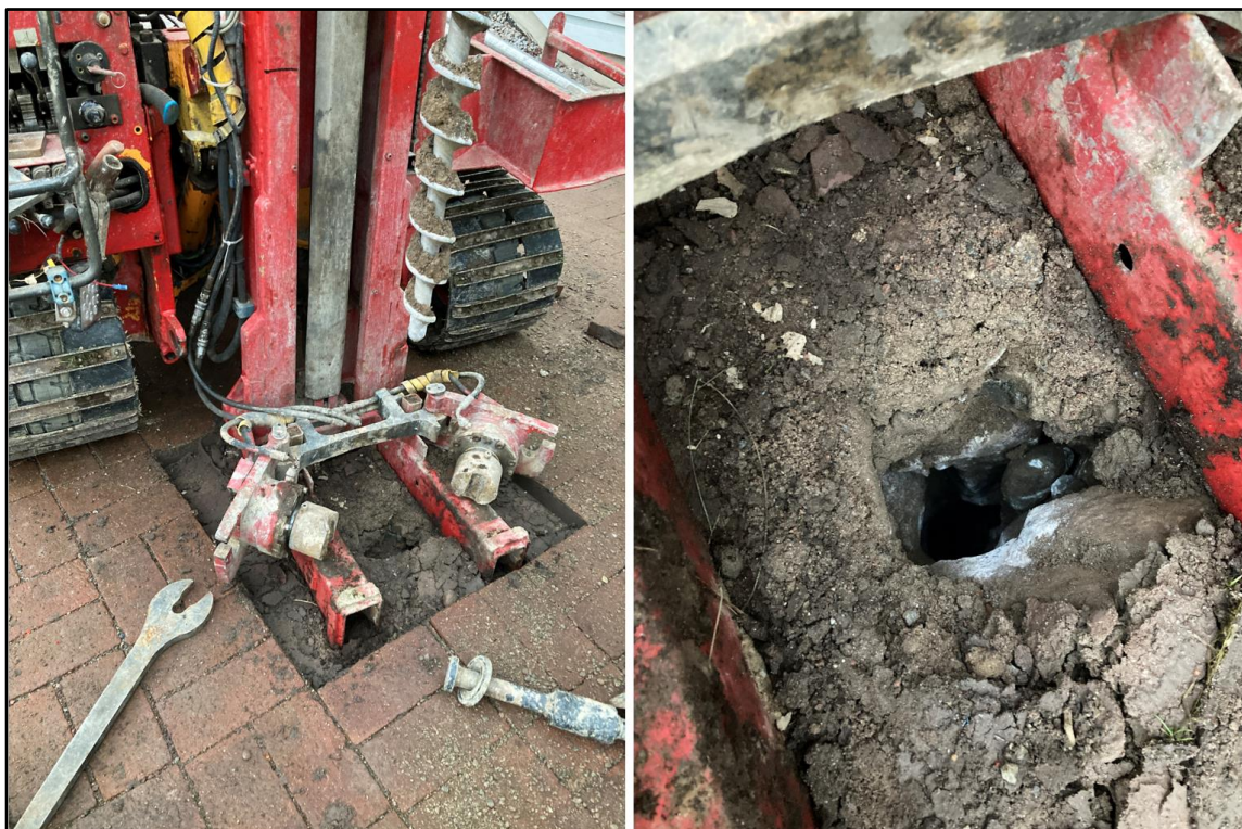
Figur 5-1 Skruvprovtagning vid provpunkt 21GS13. Vänster: Tegel avlägsnades innan provtagning. Höger: Grov fyllning kan ses redan ytligt i borrhålet, svårt att få upp material.
